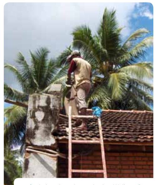
Onderhoudswerkzaamheden Welkom Dorp
